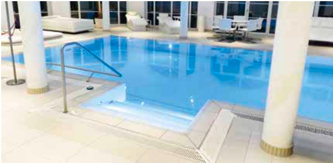
Betonbecken gefliest mit Überlaufinne
